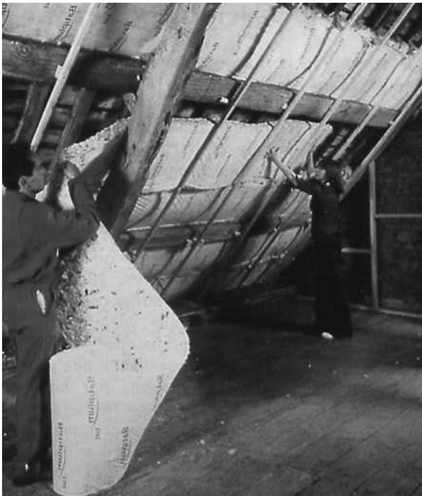
Figura 5.1. Aislante térmico a base de plumas.
