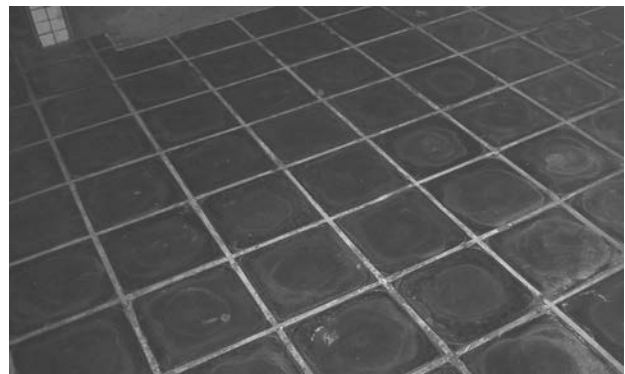
Figura 12.55. Pavimento con baldosa vitrificada a partir de fangos de EDAR.
