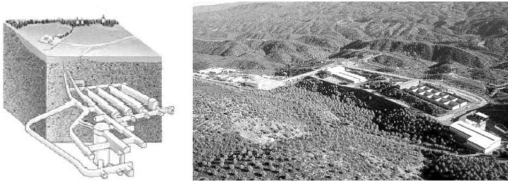
Figura 14.83. a) Modelo de instalación de almacenamiento de RBMA. b) Vista aérea de la instalación de almacenamiento de RBMA de El Cabril (Córdoba).
