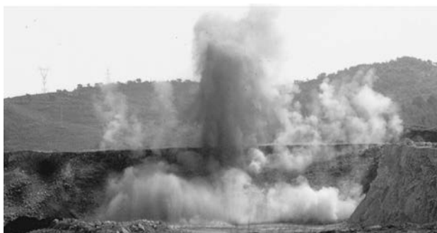
Figura 9.14. Impacto de una voladura.
