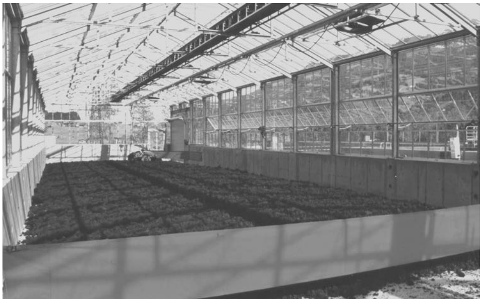
Figura.12.39. Nave-invernadero cargado con fangos deshidratados. Inicio del secado.
