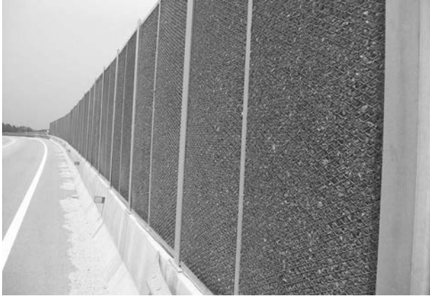
Figura 5.58. Pantalla acústica absorbente para exteriores.
