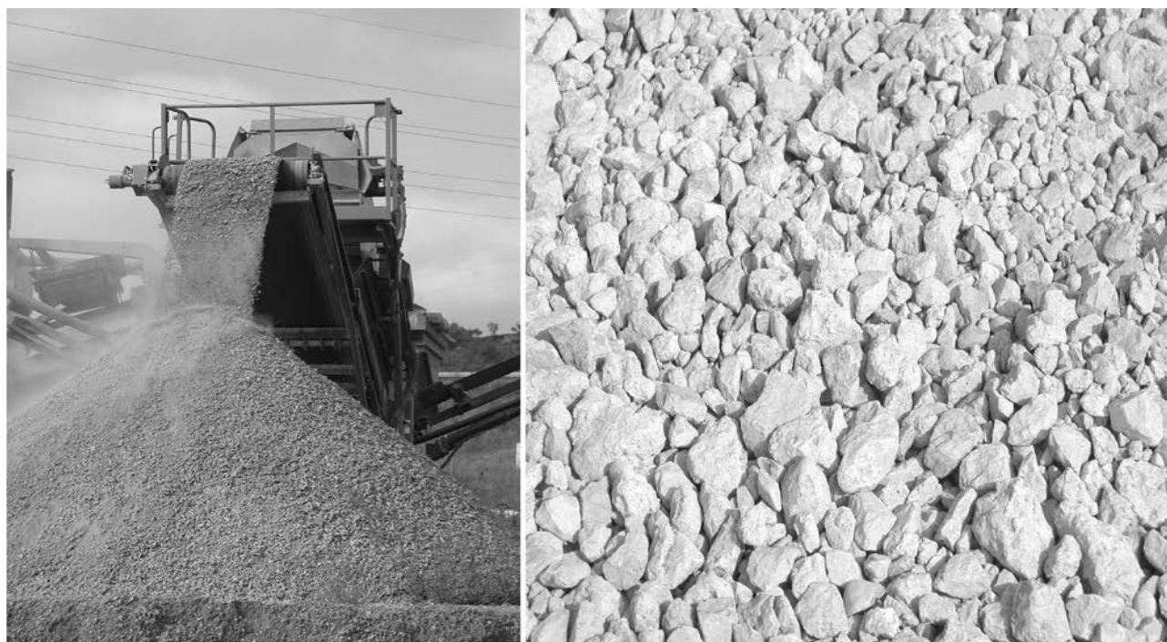
Figuras 14.57. Reutilización y reciclaje de RDC in situ . Fuente: ITeC.
