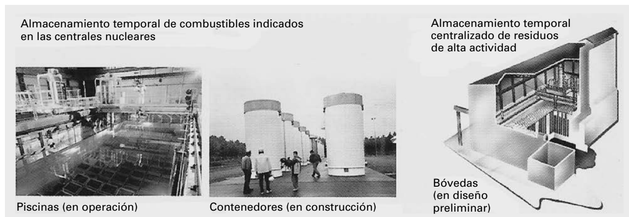
Figura 14.84. Instalaciones de almacenamiento temporal. (ENRESA. Plan de I+D 1999-2003. Rev. 2000).
